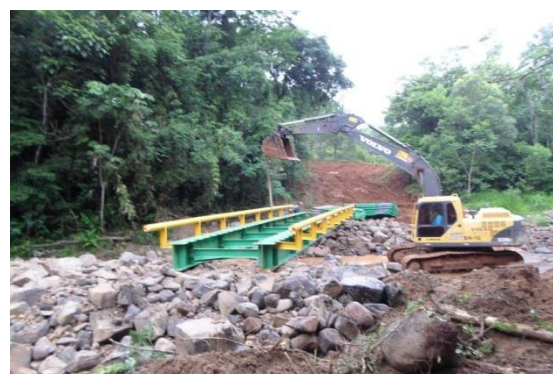
ECOALLSTEEL: 45,00 x 4,50 metros. Defensa: bate rodas e guarda corpo metálicos.
