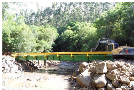
ECOALLSTEEL: 25,00 x 4,00 metros. Defensa: bate rodas metálico.
