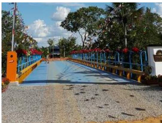
ECOALLSTEEL: 45,00 x 4,50 metros. Defensa: bate rodas e guarda corpo metálicos.
