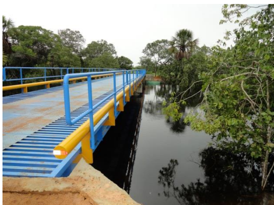
ECOALLSTEEL: 45,00 x 4,50 metros. Defensa: bate rodas e guarda corpo metálicos.
