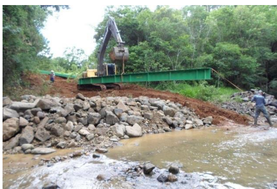
ECOALLSTEEL: 45,00 x 4,50 metros. Defensa: bate rodas e guarda corpo metálicos.
