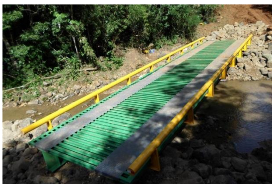
ECOALLSTEEL: 25,00 x 4,00 metros. Defensa: bate rodas metálico.
