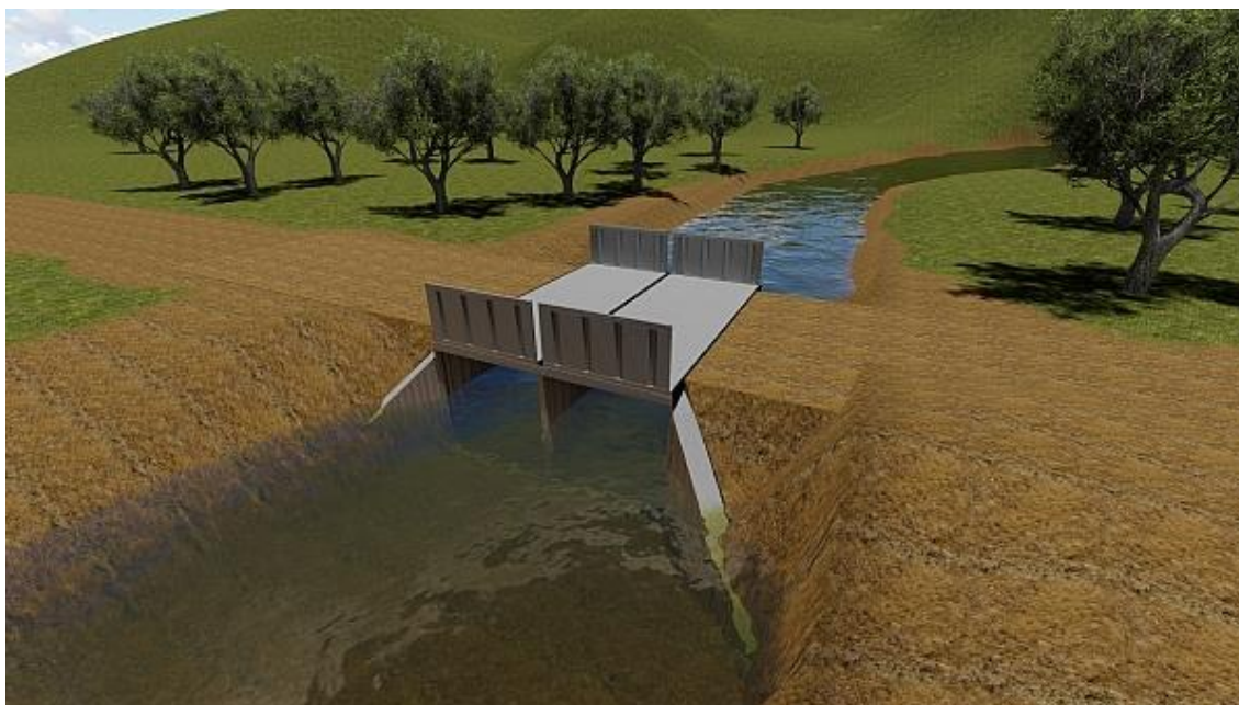
ECOADUELA: 5,00 x 6,00 metros. Defensa: guarda corpo metálico.
