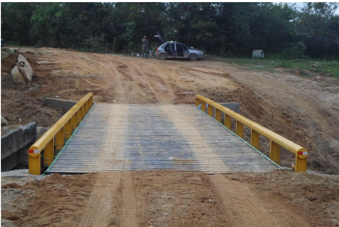
ECOWOODEN: 12,00 x 3,50 metros. Defensa: bate rodas metálico.
